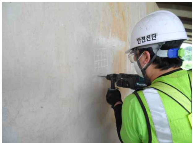
탄산화깊이 측정 현황
