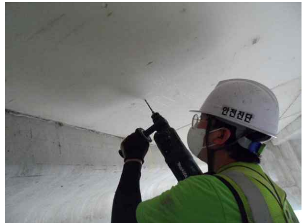
탄산화깊이 측정 현황
